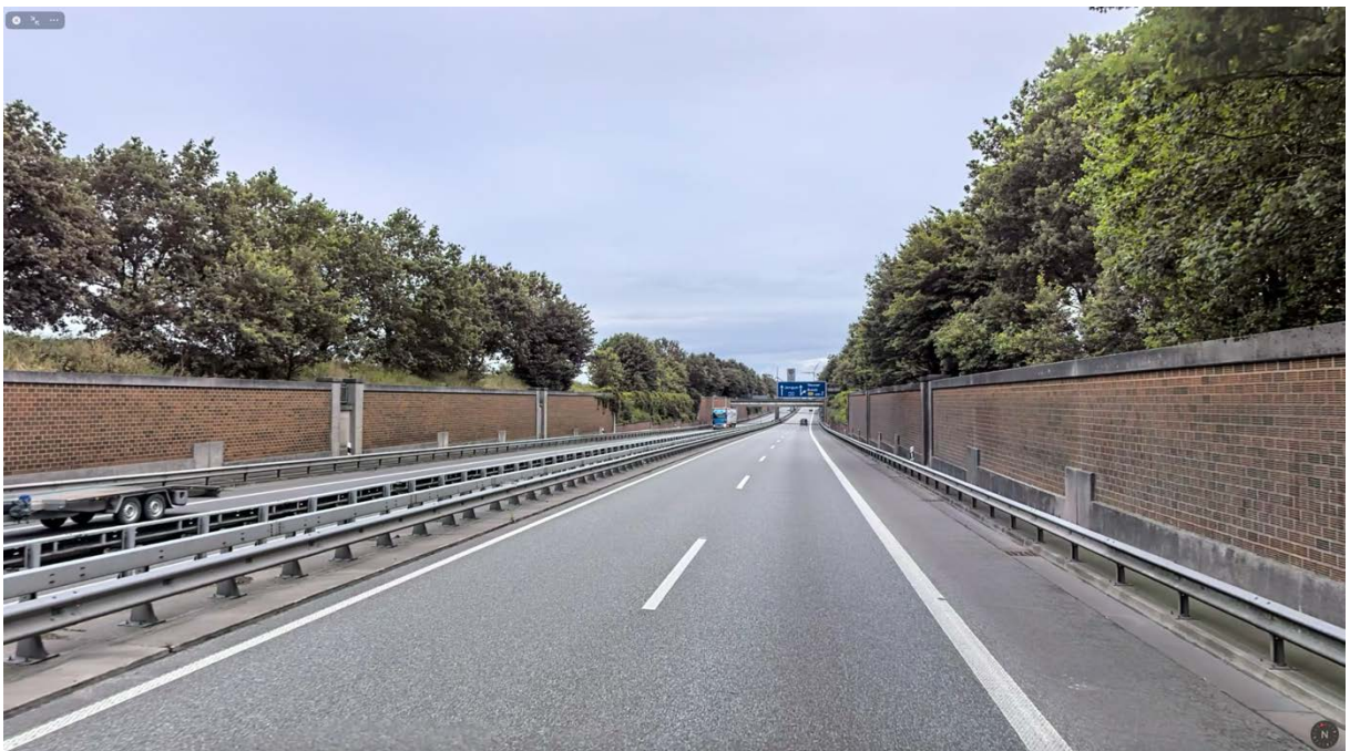
ABBILDUNG 11: BLICK AUF IP 4 IN FAHRTRICHTUNG NORD; LINKS IM BILD SOLL HINTER DEM LÄRMSCHUTZWALL DIE GEPLANTE FFPV-ANLAGE ENTSTEHEN (QUELLE: APPLE KARTEN, ABGERUFEN AM 22.12.23)
