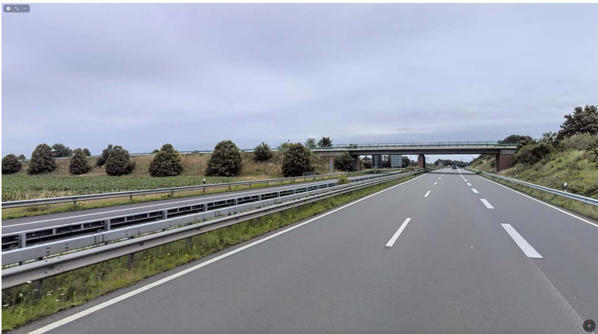
ABBILDUNG 9: BLICK AUF IP 2 IN FAHRRICHTUNG NORD; LINKS IM BILD SOLL DIE GEPLANTE FFPV-ANLAGE ENTSTEHEN (QUELLE: APPLE KARTEN, ABGERUFEN AM 22.12.23)
